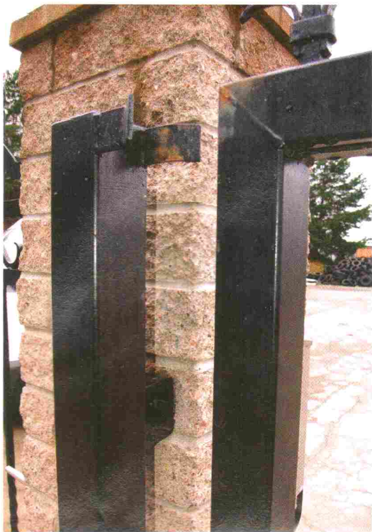
▲ Lükandvärav toetub suletud asendis tugirullikule, mis võtab värava raskuse enda kanda ja ühtlasi fikseerib raami asendi altpoolt.
